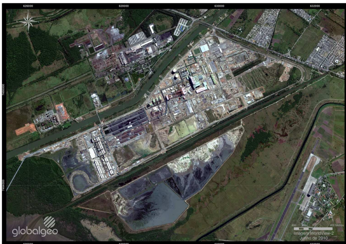
Figura 9: Área industrial da CSA.
